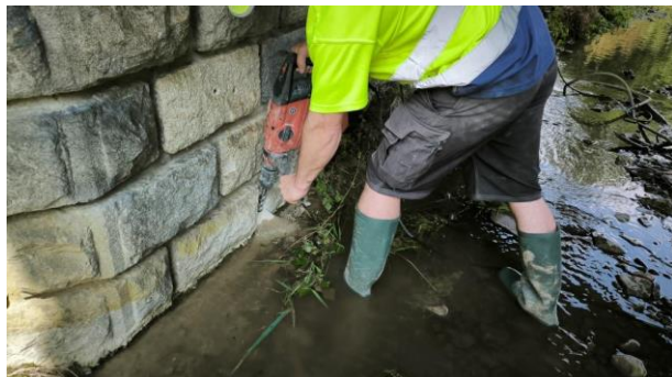
Byla detekována zakládací řada obkladového kamene, následoval beton základu.
